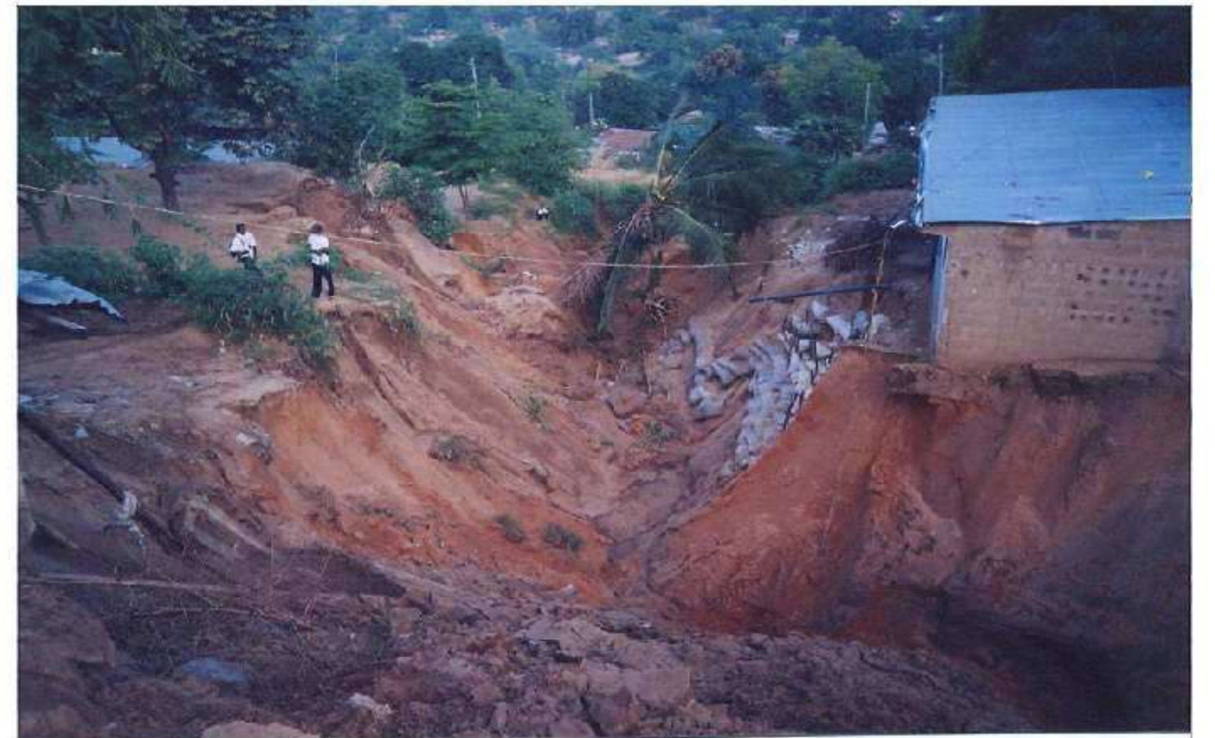
Tentative de lutte anti érosive, maisons détruites
